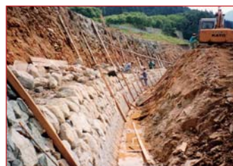
工事開始直後
